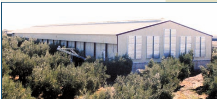
El extremo opuesto de la nave, en donde se hallan los extractores para la ventilación túnel.
